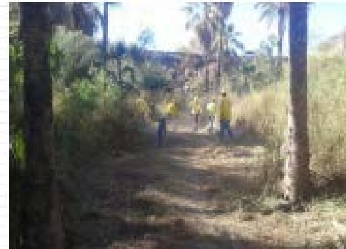
REHABILITACIÓN DE BRECHAS CORTAFUEGO
